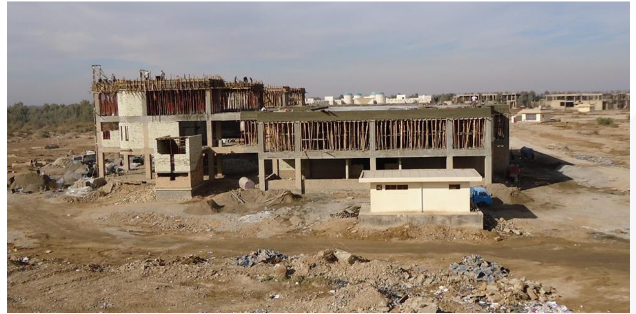
احدى أبنية الكلية قيد التشييد
